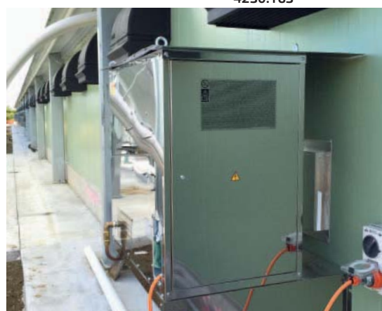
Montáž vně budovy
